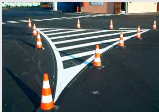
◀ REALIZZAZIONE SEGNALETICA STRADALE E SEGNALETICA INTERNA
